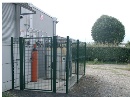
Mise en sécurité du local bouteilles gaz à l'extérieur du CIMMES.
