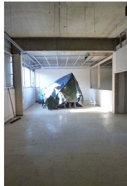
La future zone métrologie - cloisonnement réalisé
