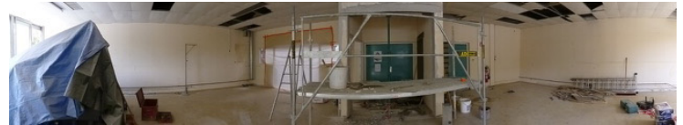
L'ensemble de l'espace mis à nu avec les travaux de reconstruction
